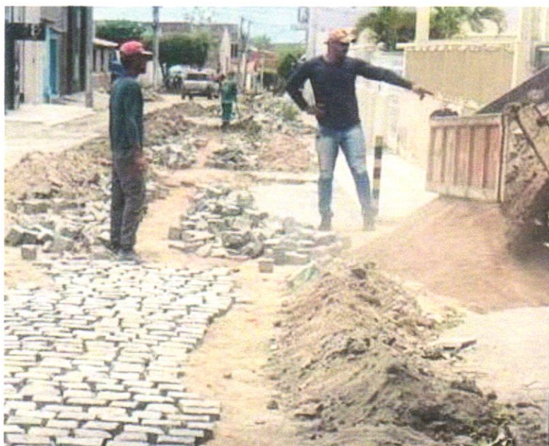
Foto 03 - ATERRO MANUAL COM SOLO ARGILLO-ARENOSO IMPORTADO E COMPACTAÇÃO MECANIZADA EM CAMADAS DE 0,20 M NO MÁXIMO
