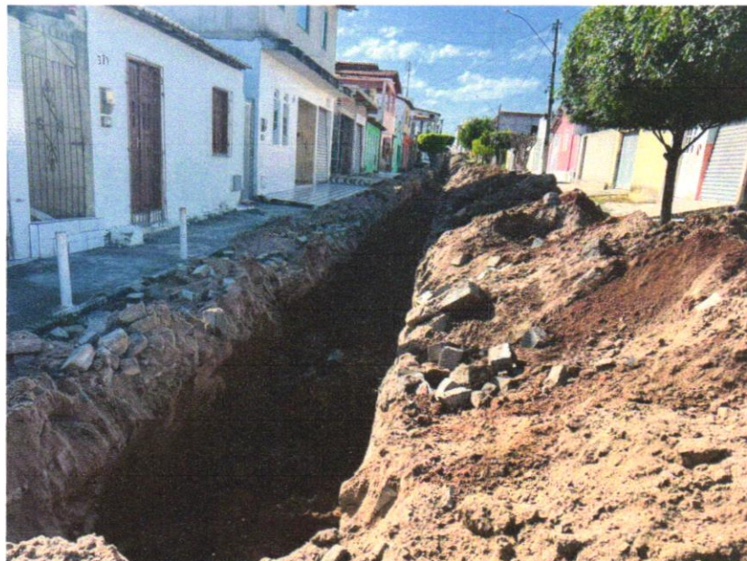
Foto 02 – ESCAVAÇÃO DE VALA
